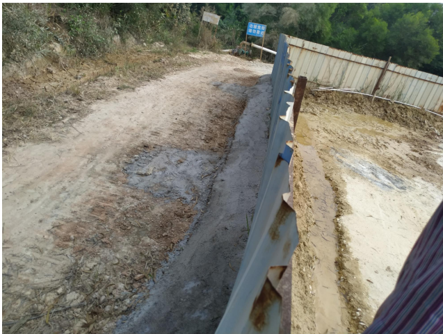
根据场区地形在生产区低处设置围堰，防止雨水外流
