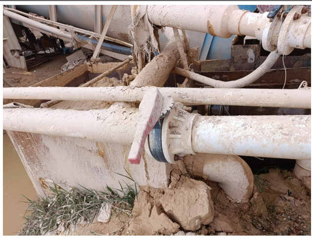
洗沙废水经收集池收集后通过埋设的洗沙废水收集管道自流依次经过沉淀池1、2
