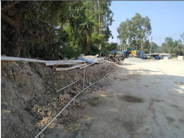
厂区安装洒水降尘装置
