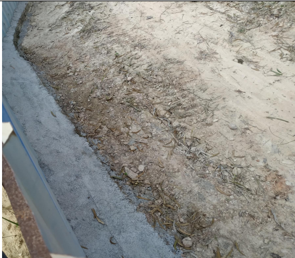
根据场区地形在生产区低处设置围堰，防止雨水外流
