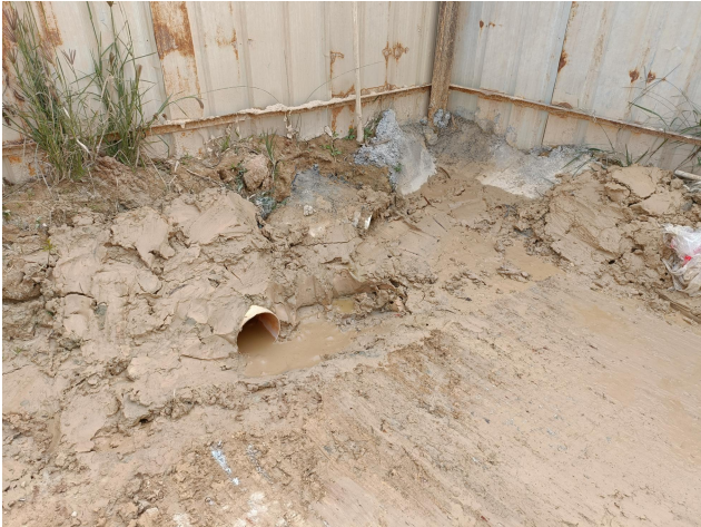
场区最低处设置截排水管入口，厂区雨、污水通过埋设的1.5米深的截排水管自流至沉淀池3
