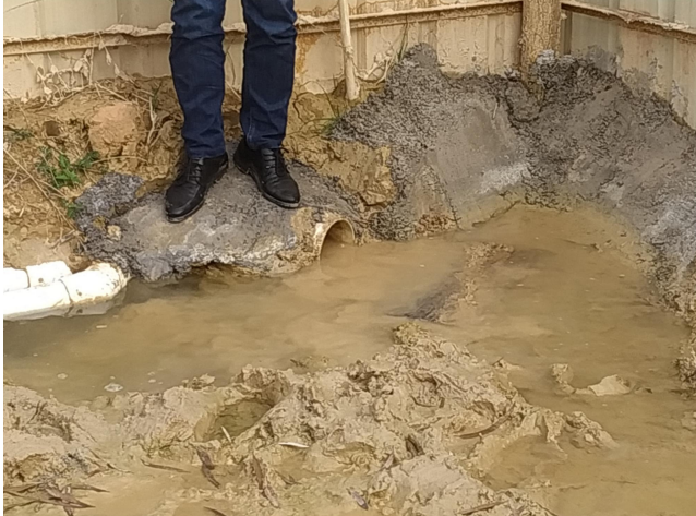
场区最低处设置截排水管入口，厂区雨、污水通过埋设的1.5米深的截排水管自流至沉淀池3
