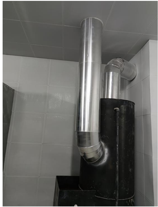
发电机烟气水幕处理装置
