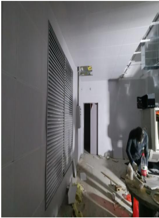
发电机房吸音墙
